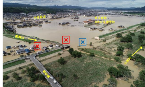
撮影日時：平成30年7月8日14時頃 浸水1日後。河道に繁茂していた樹木等が姿を表している
