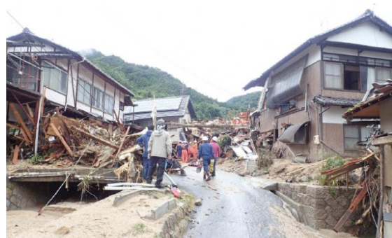
土砂流れ込みによる建物等の被災
