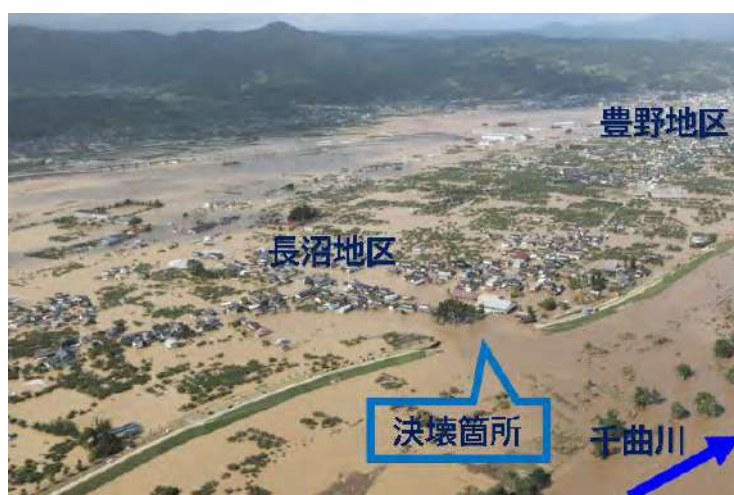
令和元年東日本台風(長野市)
