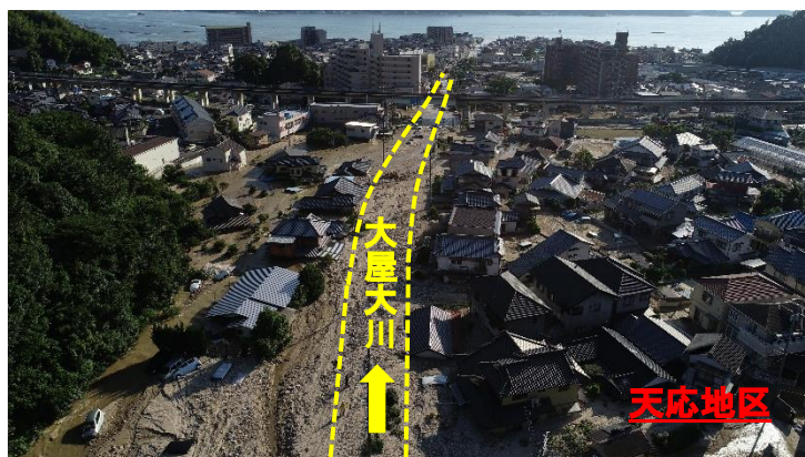
平成30年7月豪雨（呉市）
