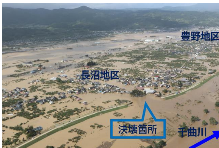
令和元年東日本台風（長野市）
