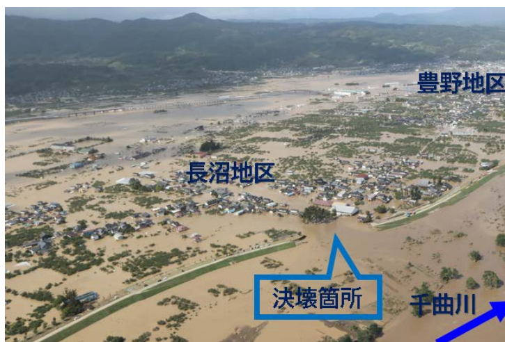
令和元年東日本台風（長野市）
