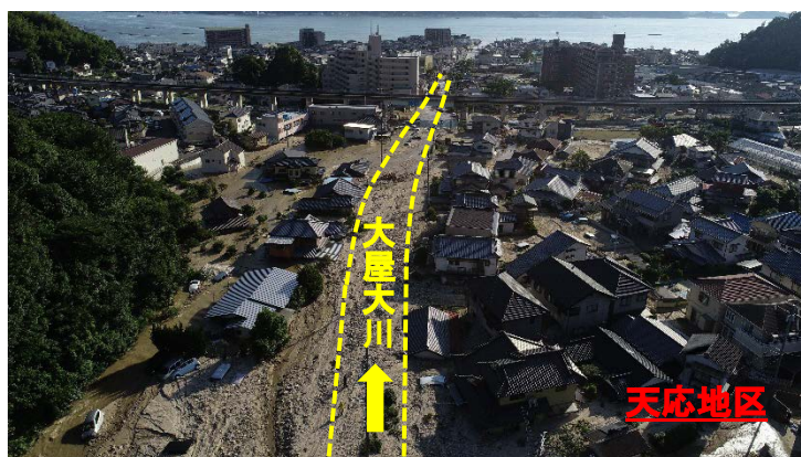
平成30年7月豪雨(呉市)
