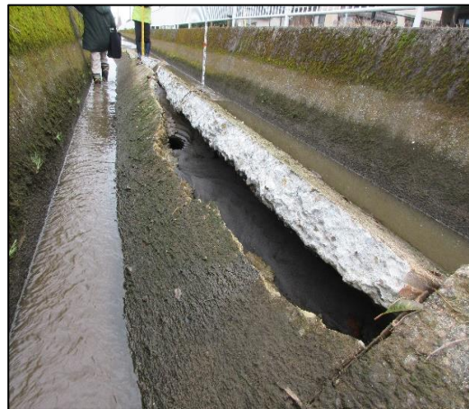
農地・農業施設被害（農業用用水路、堤体の損傷など）
