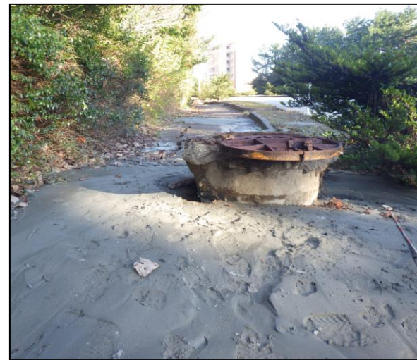
下水道被害（漏水、マンホールの隆起など）
