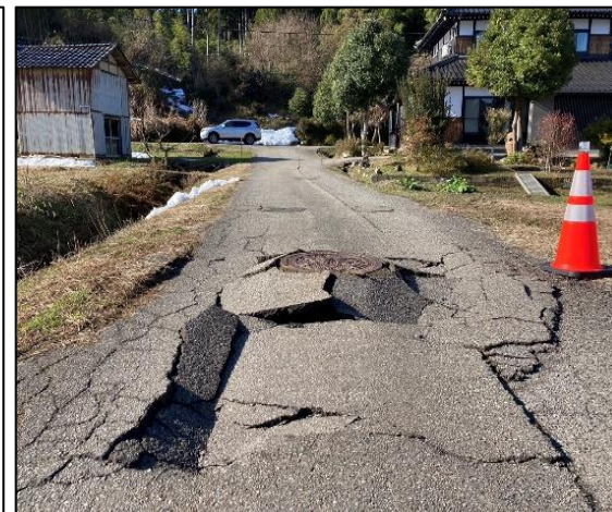
下水道被害（漏水、マンホールの隆起など）
