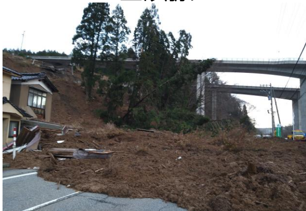
穴水町川島地内
