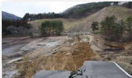
決壊した藤沼湖 (福島県東日本大震災記録写真集より)
