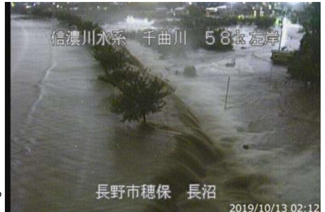
令和元年10月13日午前2時12分頃の破堤現場付近の映像
