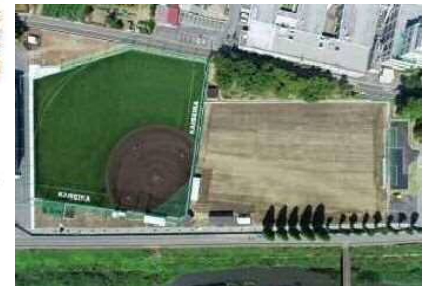
環境センタープラント跡地
